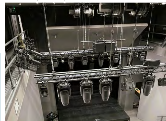
Widok z pomostu technicznego
