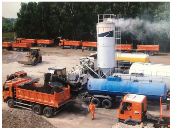
Rys. 3. Mobilna wytwórnia do recyklingu na zimno [źródło: Jakub Krasowski, Budownictwo Drogowe BUDAR Sp. z o.o.]
