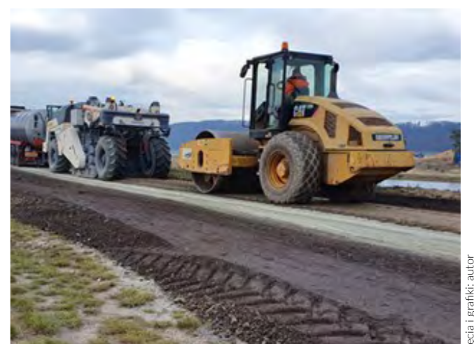
Rys. 6. Ciąg technologiczny urządzeń do recyklingu głębokiego na zimno na miejscu [źródło: P. Buczyński]
